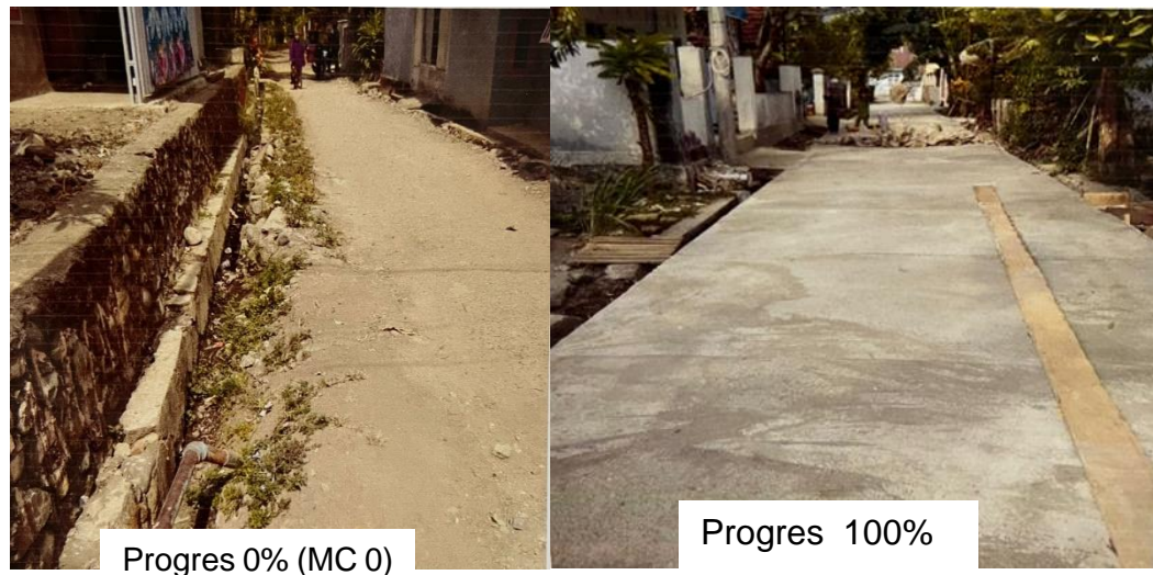
Gambar 10. Dokumentasi Kegiatan Pembangunan Jalan Lingkungan Kel. Amassangan
