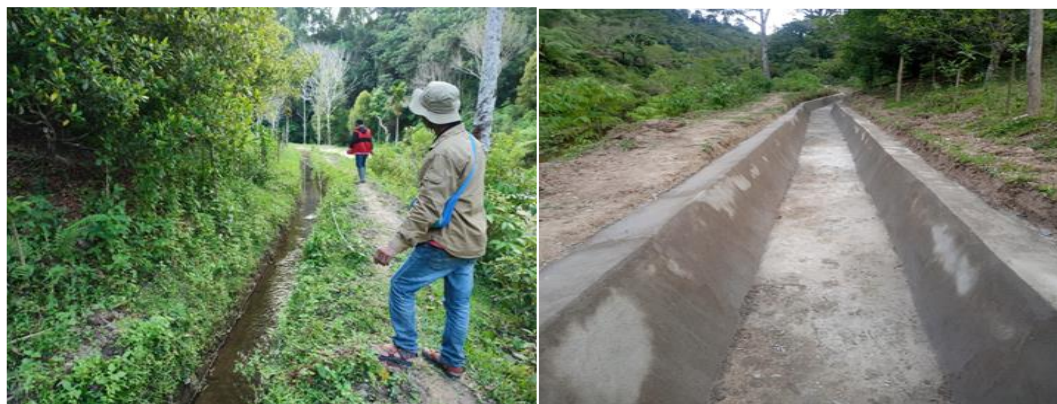
Gambar 8. REHABILITASI JARINGAN IRIGASI D.I. TIBUNG
