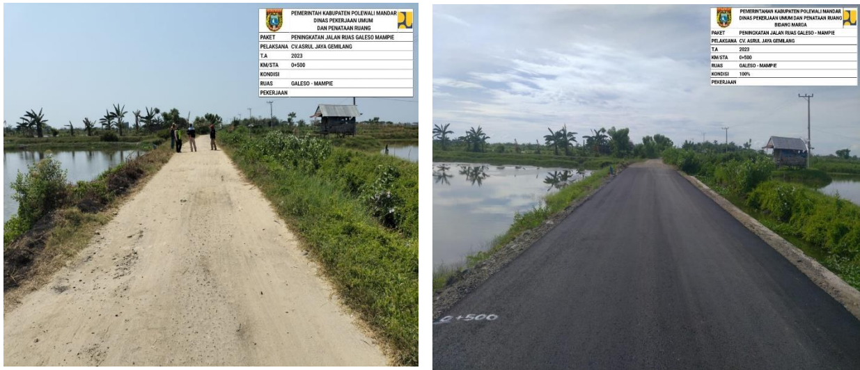
Gambar 5. Peningkatan Jalan Ruas Galeso -Mampie
