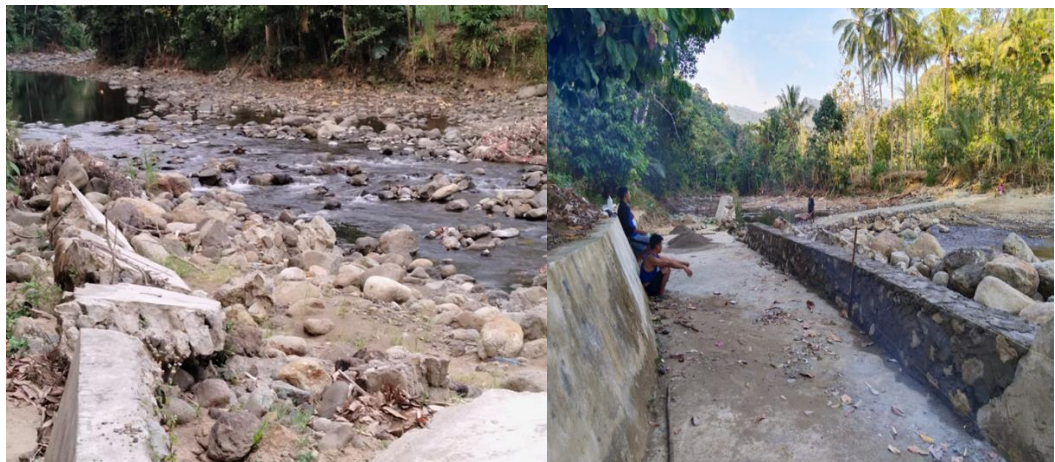
Gambar 9. Peningkatan Bendung DI Pappasaran
